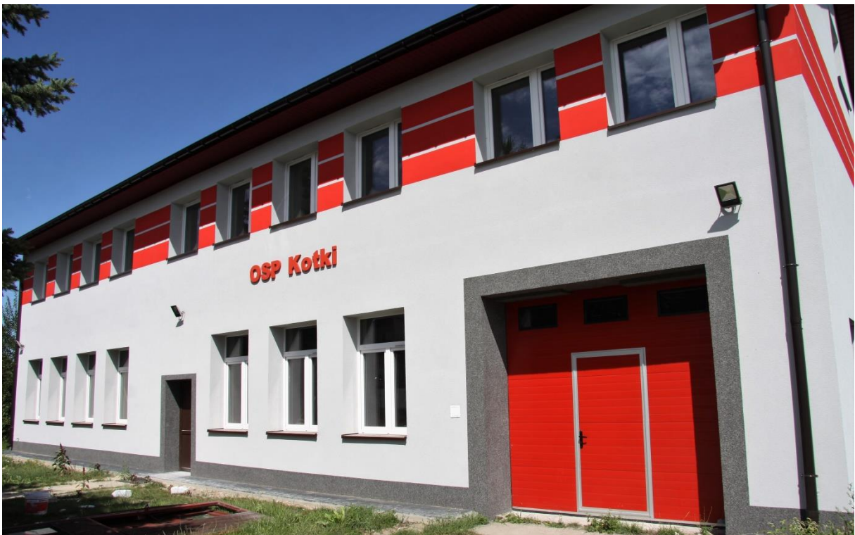
Obiekt po termomodernizacji
