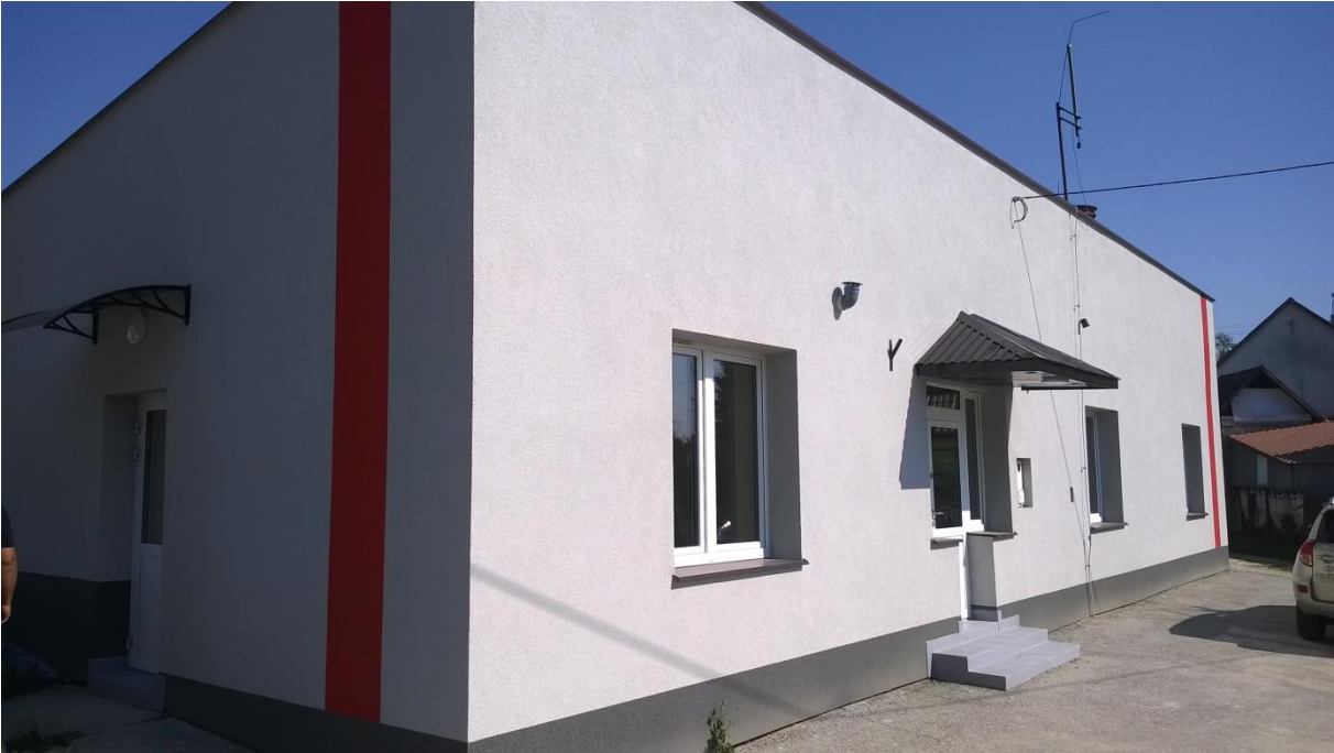
Obiekt po termomodernizacji
