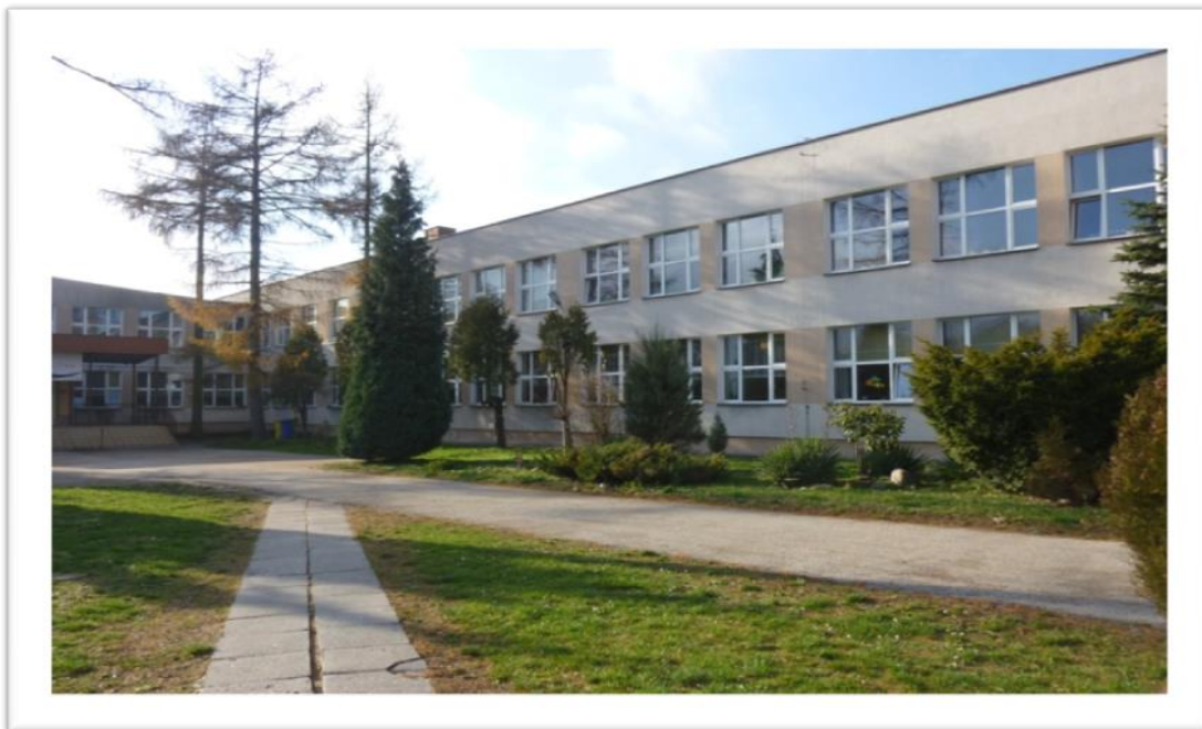
Zdjęcie 3. Publiczna Szkoła Podstawowa Nr 2 w Busku - Zdroju przed wykonaniem inwestycji
