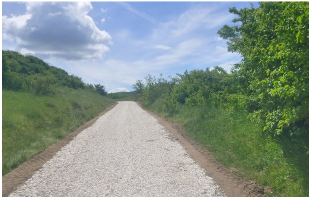
Zdjęcie 11: Remont drogi kruszywem naturalnym w sołectwie Widuchowa, fot. UMiG w Busku-Zdroju
