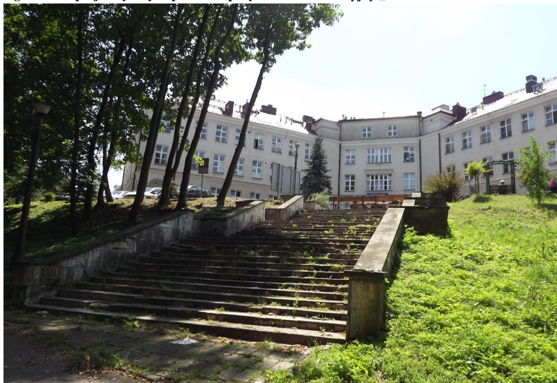
Fotografia 16 Specjalistyczny Szpital Ortopedyczno-Rehabilitacyjny „Górka” im. dr. S. Starkiewicza
