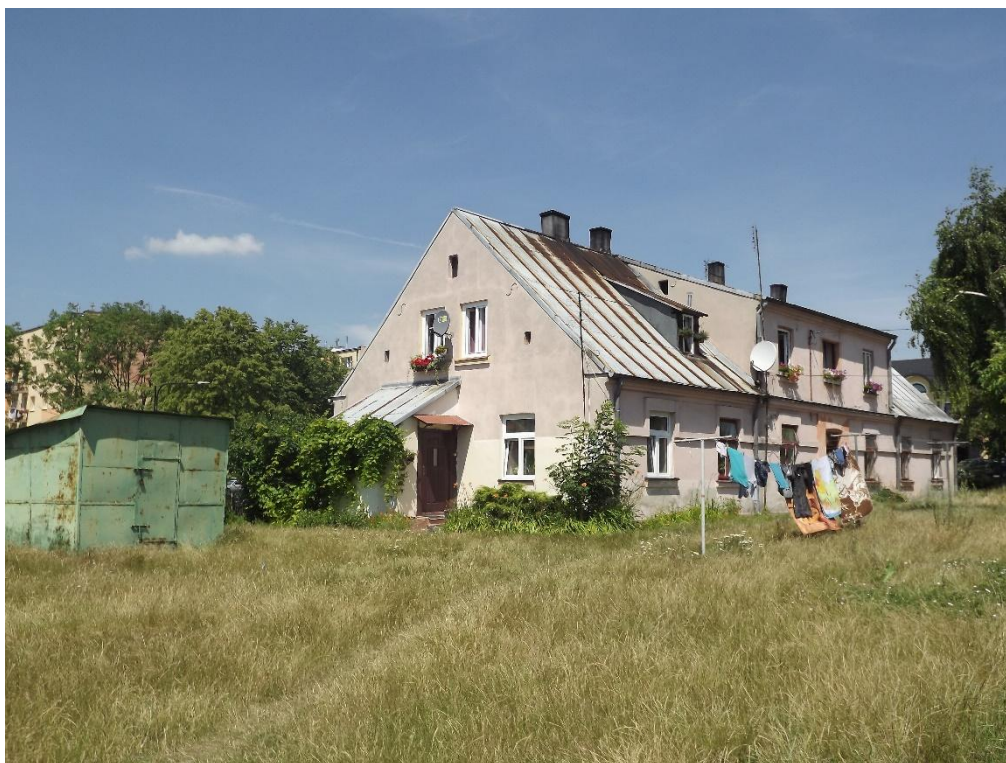
Fotografia 2 Budynek przy ul. Bocznej
