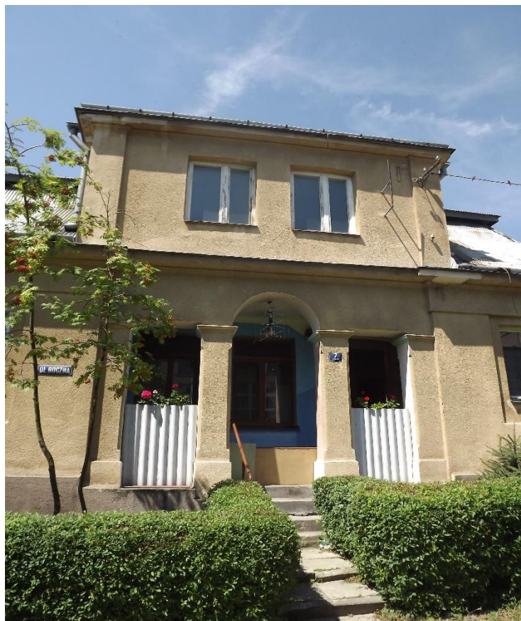
Fotografia 1 Budynek przy ul. Bocznej
