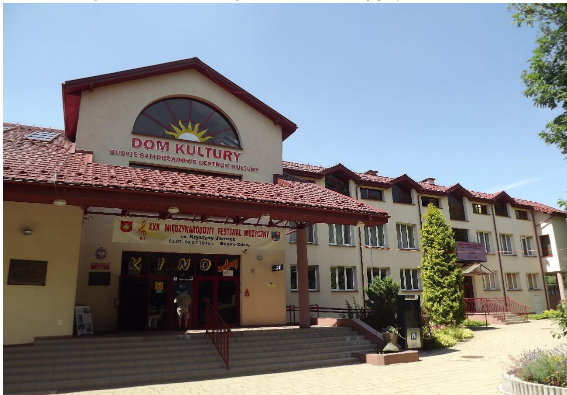
Fotografia 22 Buskie Samorządowe Centrum Kultury przy al. Mickiewicza
