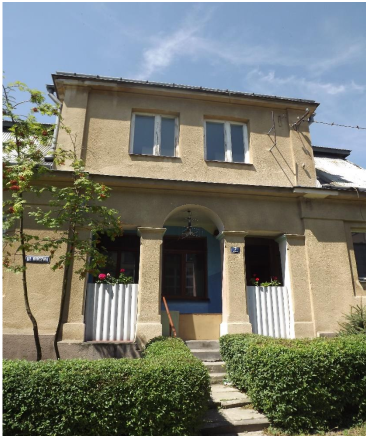
Fotografia 1 Budynek zasobów mieszkaniowych Gminy Busko-Zdrój przy ul. Bocznej
