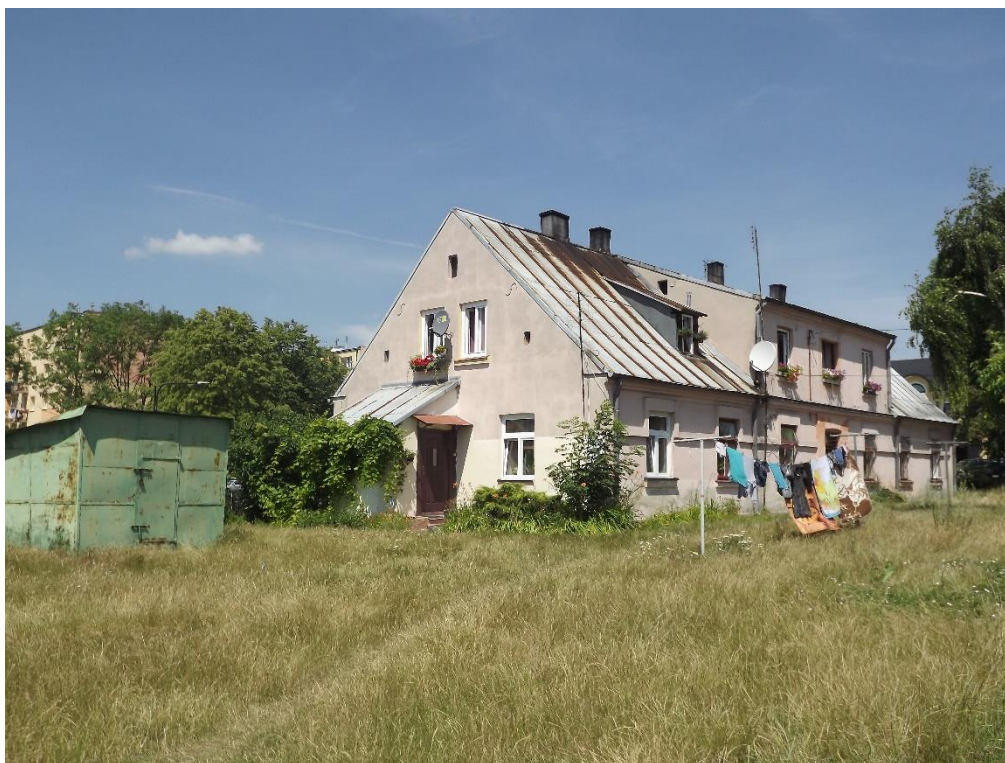
Fotografia 2 Budynek zasobów mieszkaniowych Gminy Busko-Zdrój przy ul. Bocznej
