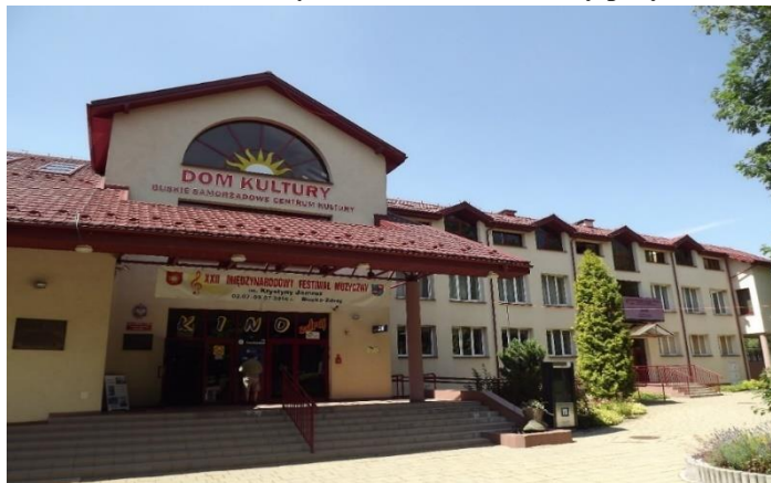
Fotografia 17 Buskie Samorządowe Centrum Kultury przy al. Mickiewicza
