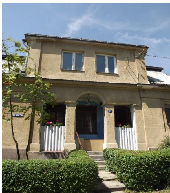
Fotografia 19 Budynek zasobów mieszkaniowych Gminy Busko-Zdrój przy ul. Bocznej – 2
