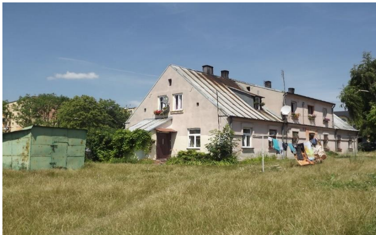
Fotografia 18 Budynek zasobów mieszkaniowych Gminy Busko-Zdrój przy ul. Bocznej – 1
